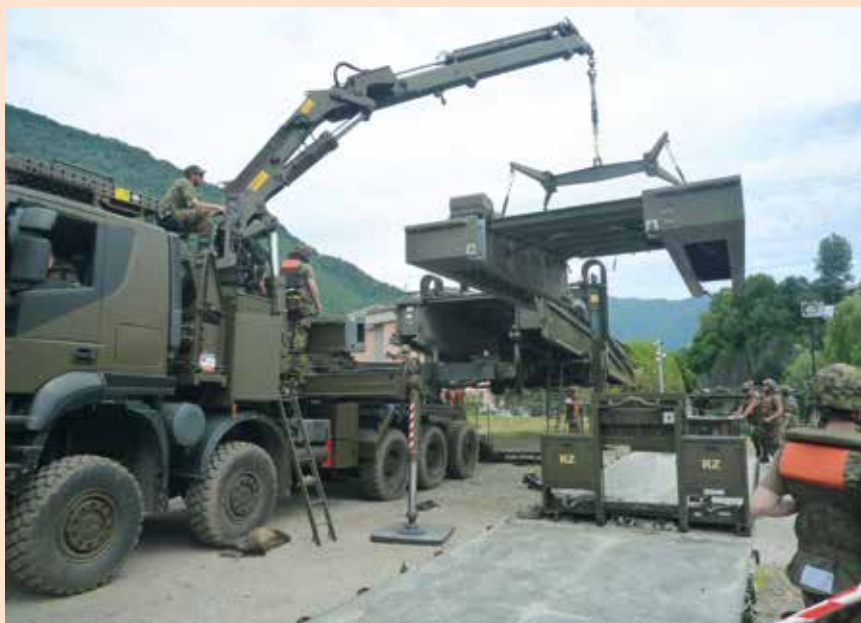
Il varo di un ponte mobile con portate di oltre 70 tonnellate. All'esercitazione hanno partecipato, per l'Esercito Italiano, il reggimento Genio ferrovieri, il 2° reggimento Genio pontieri, il 10° reggimento Genio guastatori, del 7° reggimento Difesa "Nbc" e un ospedale da campo del Reparto Sanità "Milano".
